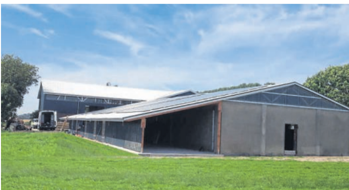
Diese im Sommer 2016 gebaute Photovoltaikanlage ist etwas ganz Besonderes – das hier verbaute Modul wurde mit dem „Intersolar Award 2016“ ausgezeichnet.
